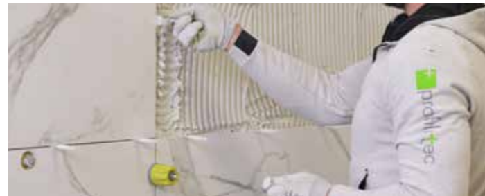
Stendere la colla per piastrelle sulle pareti e procedere con l'incollaggio.
