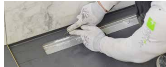
Pulire la cavità della canalina da possibili residui di malta e polvere assicurandosi che non possano cadere nello scarico.
