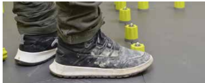
Rimuovere le manopole Leveltec dando un colpo secco lungo la direzione della fuga.
